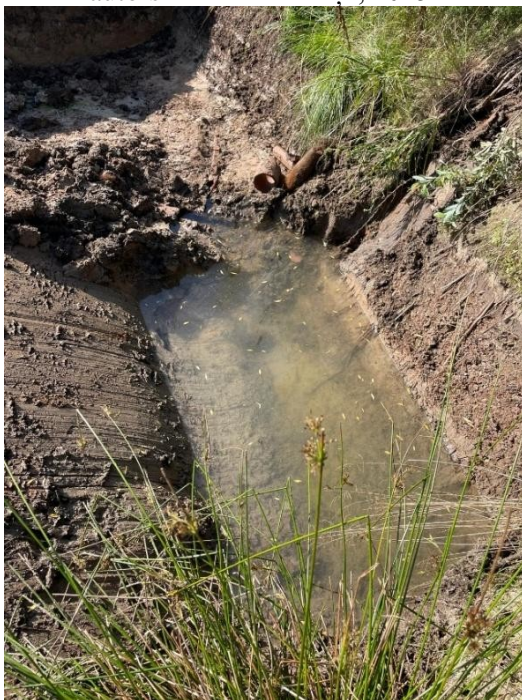
Attēls Nr. 6. Drenāžas atjaunošana pie pirmā bioreaktora. Attēla autors - Gunārs Žīdeņš, 2025.
