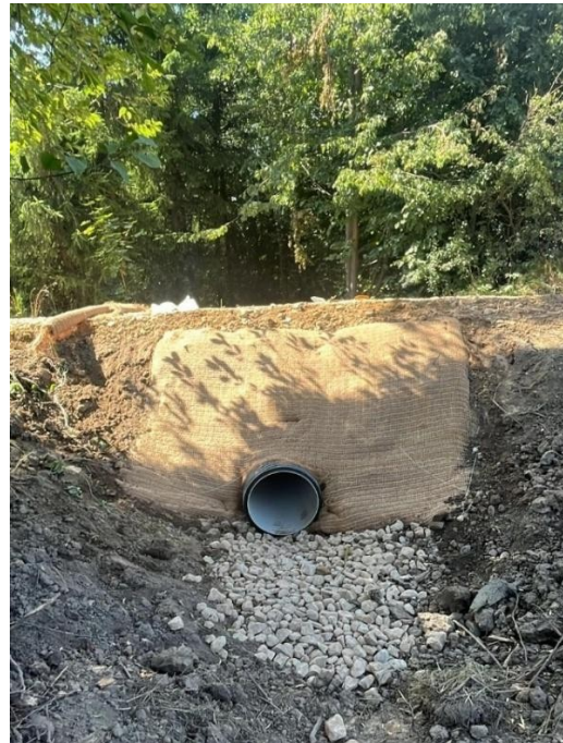
Attēls Nr. 5. Caurtekas pārbūve. Attēla autors - Gunārs Žīdeņš, 2025.
