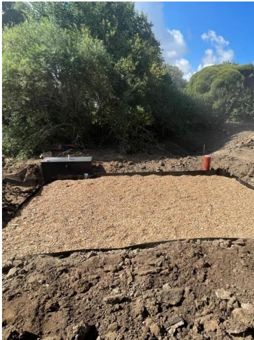
Attēls Nr. 4. Pirmā bioreaktora izbūve. Attēla autors - Gunārs Žīdeņš, 2025.
