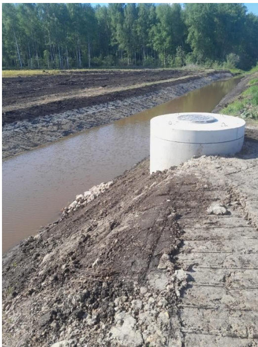
Attēls Nr. 30. Izbūvēta aka ūdens paņemšanai. Attēla Autors – Gunārs Žideņš, 2025.
