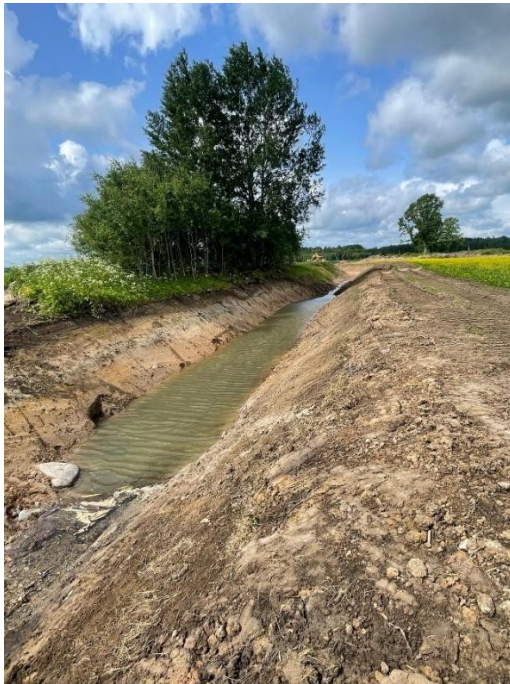
Attēls Nr. 50. Būve Nr. 2 - Sedimentācijas baseins. Attēla autors - SIA “Meliorceltnieks”, 2025.
