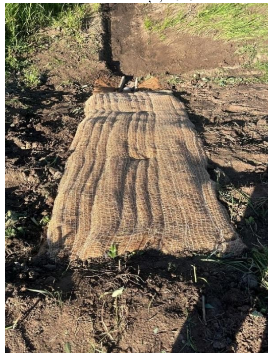
Attēls Nr. 7. Drenu kolektora izteka. Attēla autors - Gunārs Žīdeņš, 2025.
