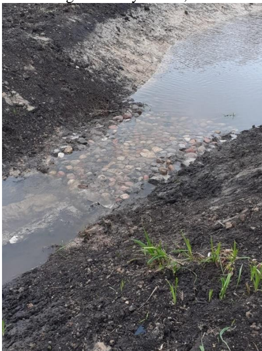
Attēls Nr. 26. Akmeņu krāvējs pie sedimentācijas baseina ietekas. Attēla Autors - Gunārs Žideņš, 2025.
