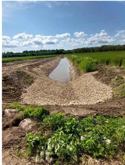
Attēls Nr. 43. Ūdensnotekas stiprinājums aiz Būves Nr.1. Attēla autors – Gunārs Žideņš, 2025.
