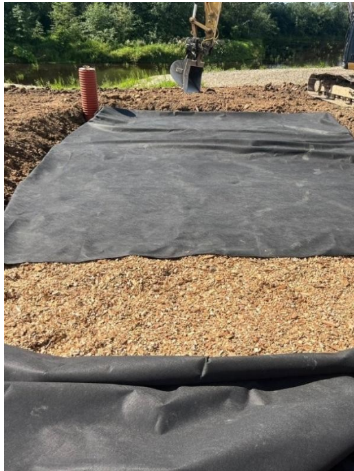
Attēls Nr. 12. Otrā bioreaktora izbūve. Attēla autors - Gunārs Židenš, 2025.
