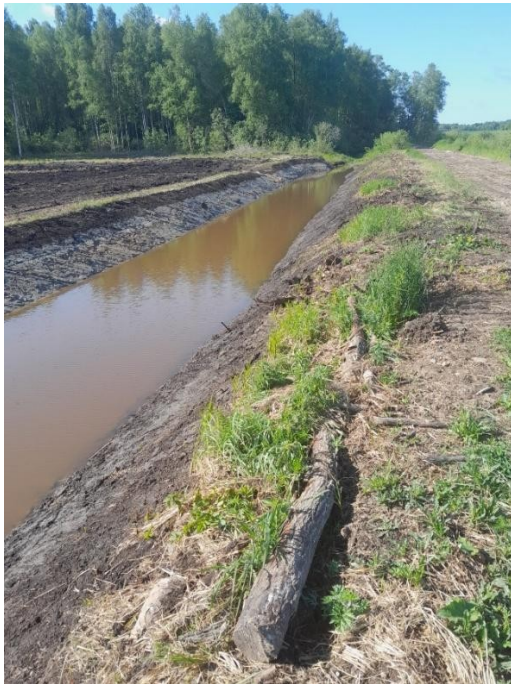
Attēls Nr. 28. Ierīkotais sedimentācijas baseins. Attēla Autors – Gunārs Žideņš, 2025.
