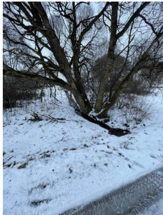
Attēls Nr. 3. Atjaunojamā grāvja foto pirms atjaunošanas. Attēla autors - SIA “Progressive Systems”, 2023.
