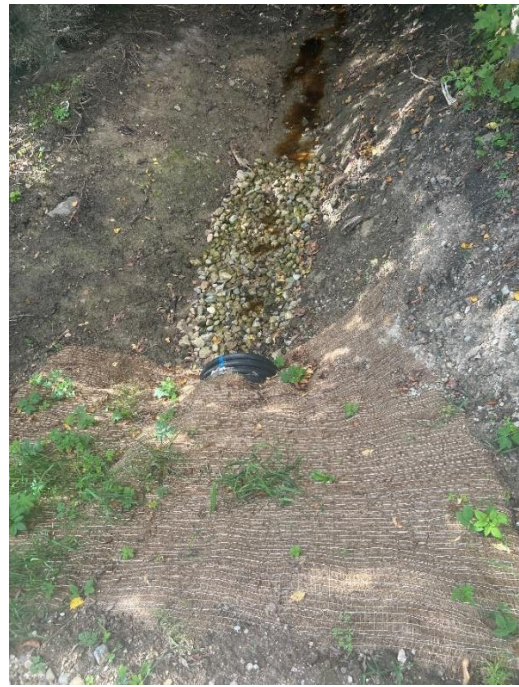
Attēls Nr. 9. Caurtekas pārbūve Attēla autors – Ilze Apenīte, 2025.
