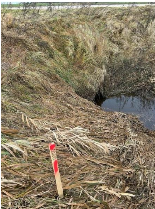
Attēls Nr. 18. Skats uz caurtekas izplūdi pie pik. 00/00, pirms darbu veikšanas. Attēla autors - SIA “Progressive Systems”, 2024.
