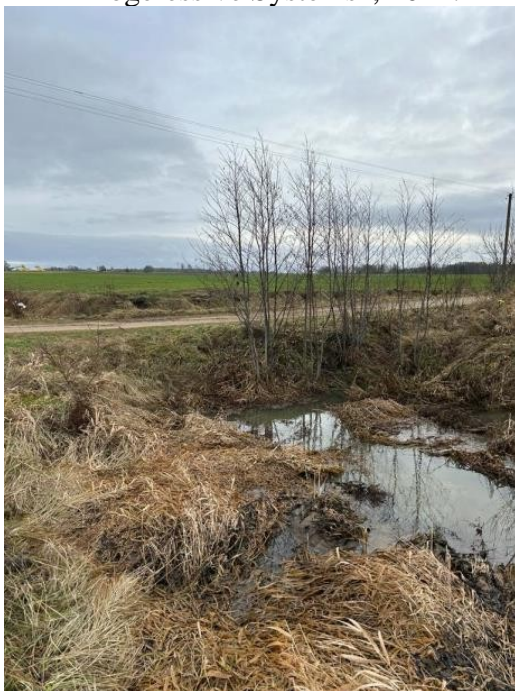
Attēls Nr. 36. Būves Nr. 1 izplūde. Attēla autors - SIA “Progressive Systems”, 2024.
