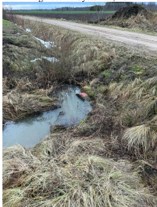
Attēls Nr. 37. Būves Nr1 ieplūde. Attēla autors - SIA “Progressive Systems”, 2024.
