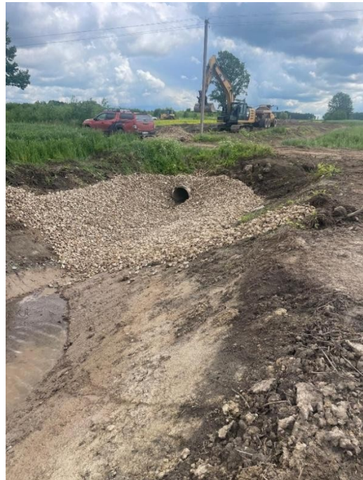
Attēls Nr. 51. Caurtekas pārbūve. Attēla autors - SIA “Meliorceltnieks”, 2025.
