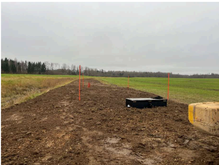
2. Piesātinātās buferjoslas izbūve – drenāžas cauruļu izbūve tranšējā, kontrolakas ar ūdens līmeņa regulēšanu izbūve, nostiprinātas iztekas izbūve grāvī.
