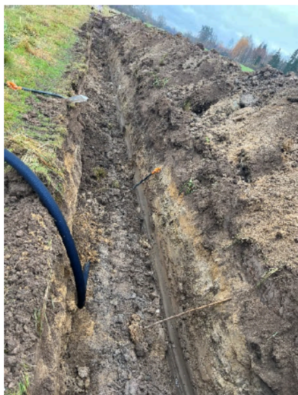
2. Piesātinātās buferjoslas izbūve – drenāžas cauruļu izbūve tranšējā, kontrolakas ar ūdens līmeņa regulēšanu izbūve, nostiprinātas iztekas izbūve grāvī.
