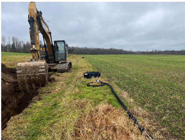
2. Piesātinātās buferjoslas izbūve – drenāžas cauruļu izbūve tranšējā, kontrolakas ar ūdens līmeņa regulēšanu izbūve, nostiprinātas iztekas izbūve grāvī.
